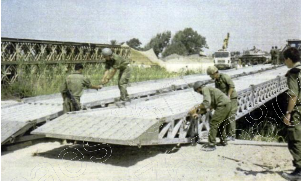
圖 18 RDB 重機橋橋頭坡道架設
