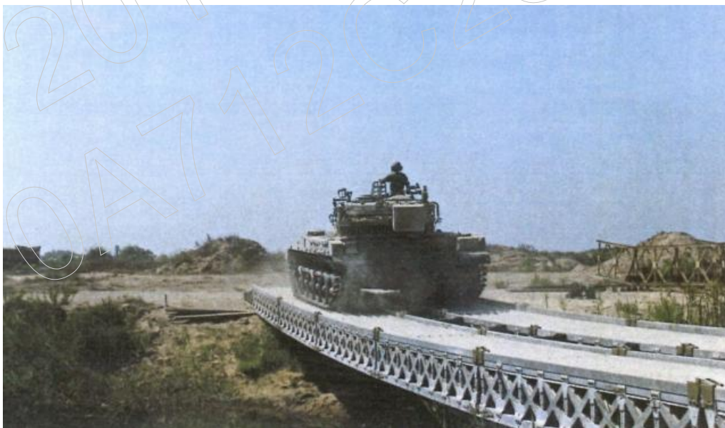
圖 17 長度 34 公尺 RDB 重機橋實驗情形
