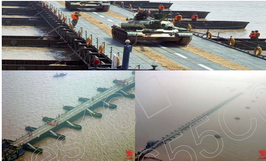
圖十一 重型舟橋架設通過長江
