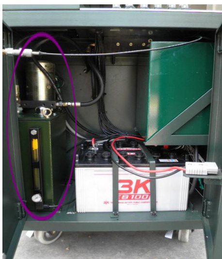
圖五 油壓單元及電瓶
