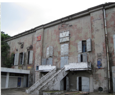
日治時代，建於無線電信所內的磚造管制室和工廠區（自後方所攝）。
