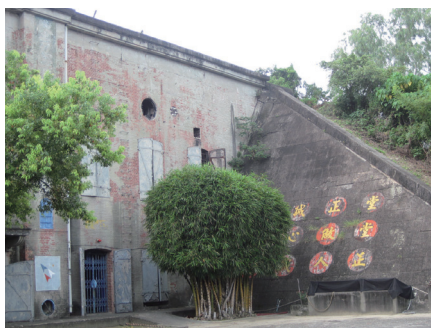
前期磚造中央管制室（第一送信所，又稱大碉堡），南北兩側之混凝土質坡面建築物。
