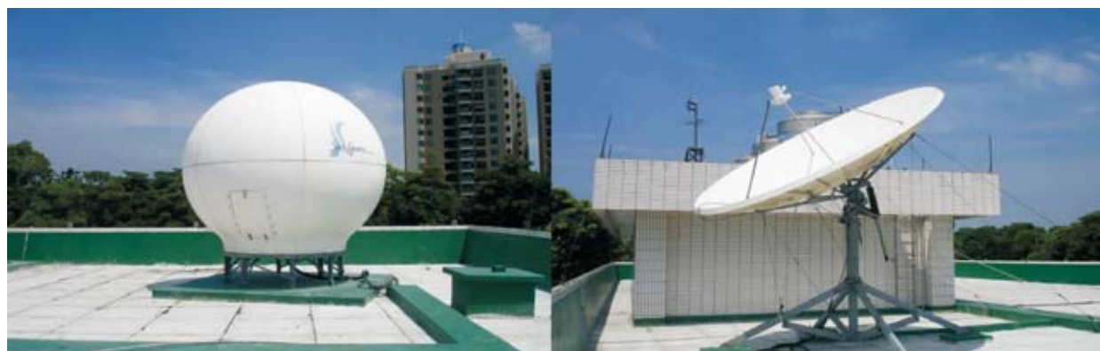
圖八 左方為白色球形天線罩為固定式MODIS「繞極」衛星資料地面接收系統，右方為固定式MTSAT「同步」衛星資料地面接收系統
