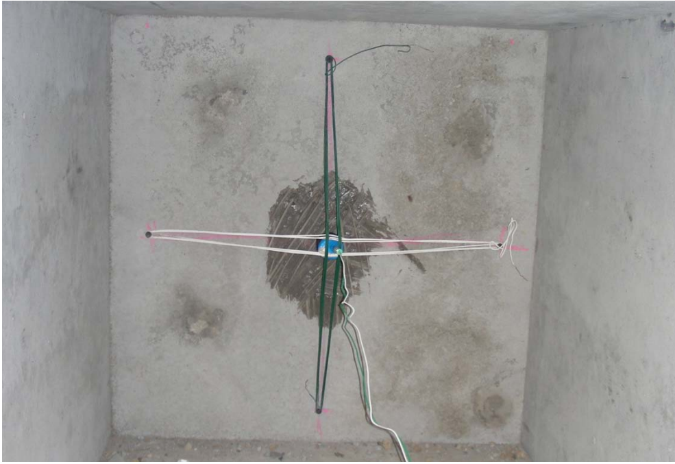
圖三 鋼筋混凝土結構內部裝藥情形
