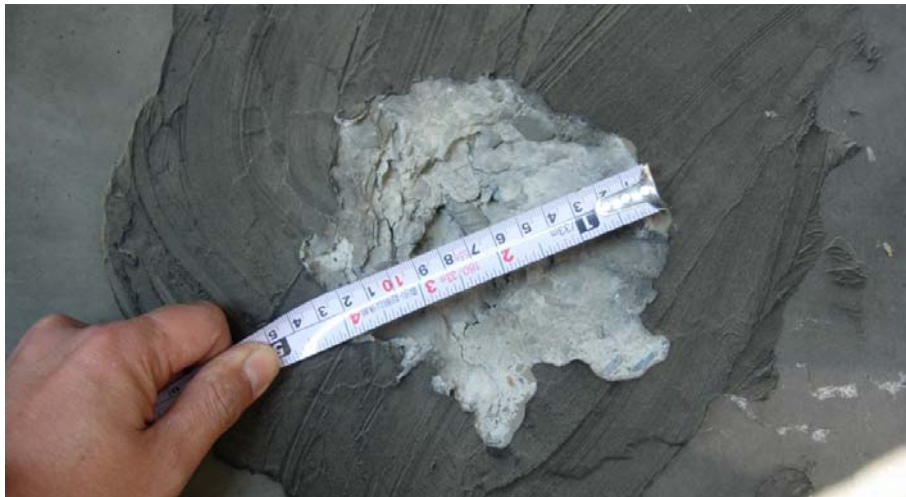
圖十三 鋼筋混凝土結構 70 克 C4 炸藥內部爆炸後-內部炸坑狀況
