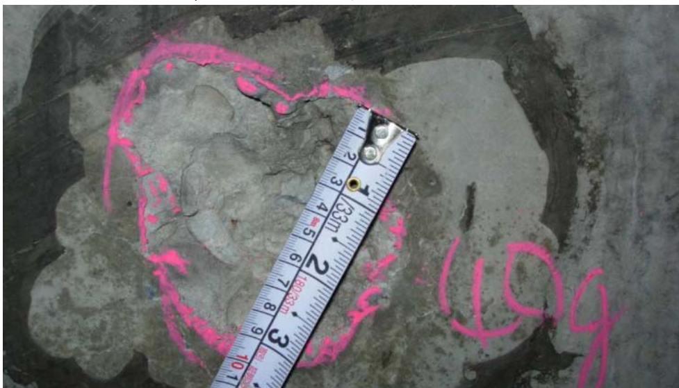
圖八 鋼筋混凝土結構於 40 克 C4 炸藥內部爆炸後-內部狀況
