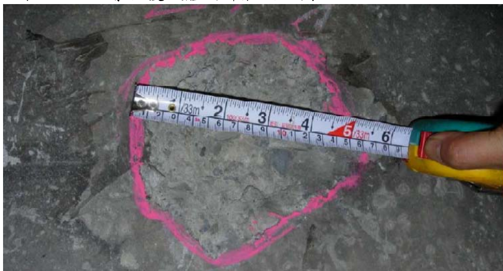
圖六 鋼筋混凝土結構於第一次 25 克 C4 炸藥內部爆炸後-內部狀況
