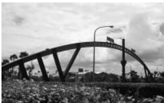
跨越臺1號道路，並象徵北回歸線經過路線的鋼質標示。
