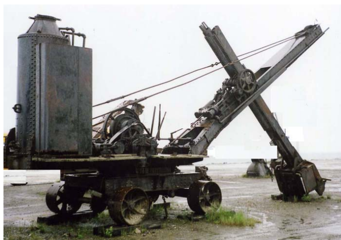
圖一 蒸氣挖土機
