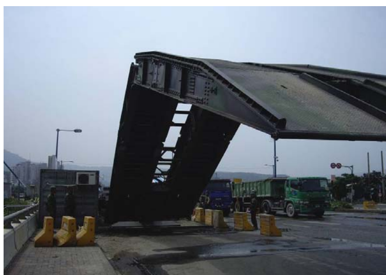
圖十 M48A5 履帶機動橋搶修作業
