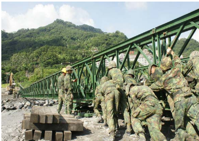
圖九 M2 桁橋搶修作業
