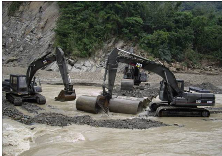
圖七 道路搶修作業
