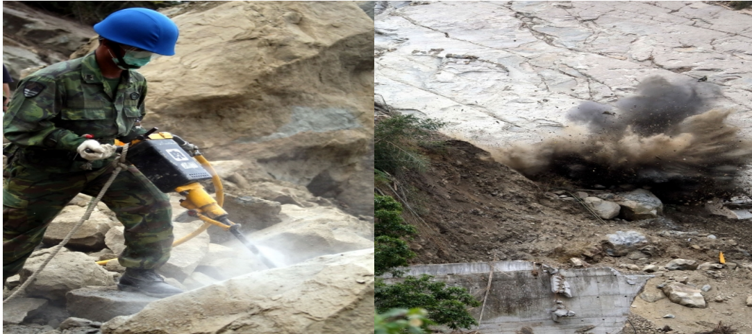
圖六 巨石爆破作業
