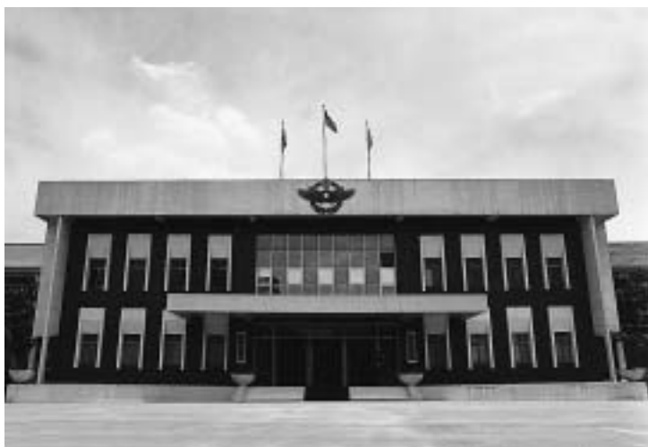
仁愛營區部本部大樓
