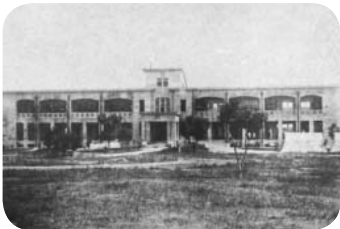
昔由日軍於機場內所興建之本部大樓，今為「天祥大樓」
