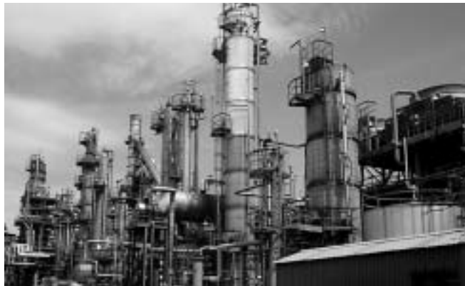
高雄楠梓煉油廠部分廠區之外觀（載自高市府都發局網站）
