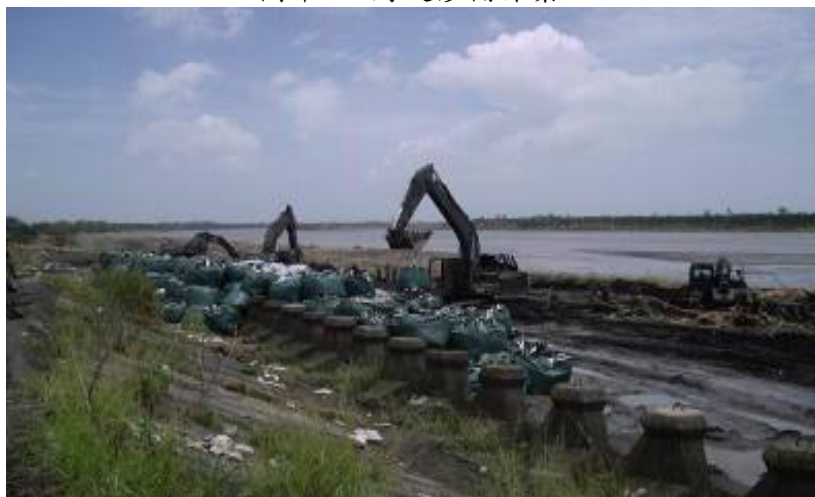
圖十一 河堤修補作業
