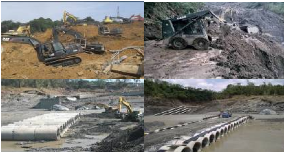
圖八 道路搶修作業
