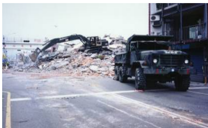
圖三 陸軍工兵部隊協助危屋拆除
