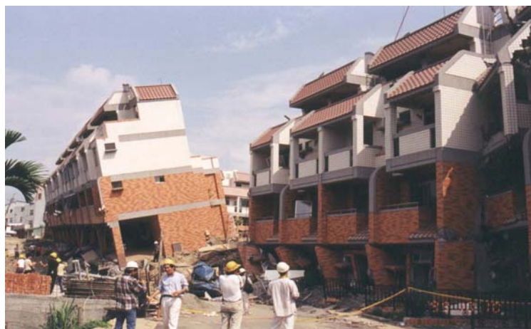
圖二 地震斷層通過造成住宅傾斜
