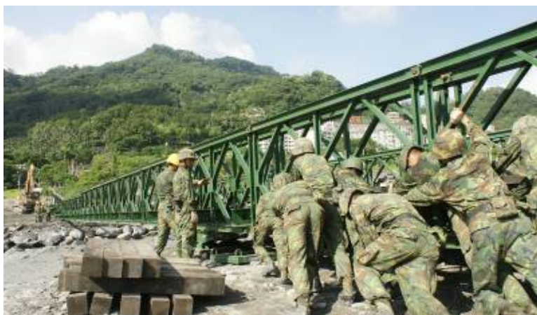
圖十 橋樑架設作業
