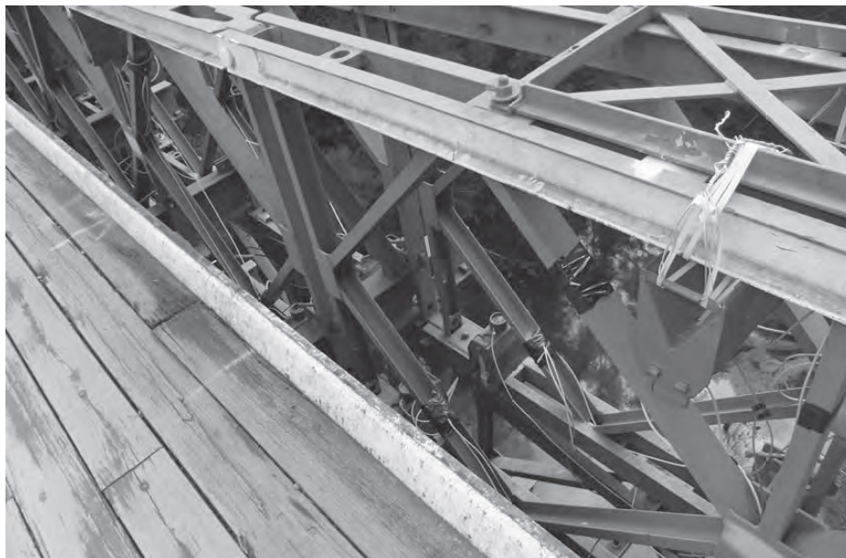
框桁橋爆藥設置情形
