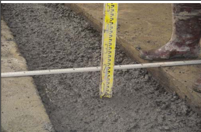
(7)級配混凝土回填
