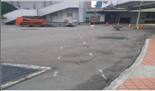
(1)開挖範圍標示
