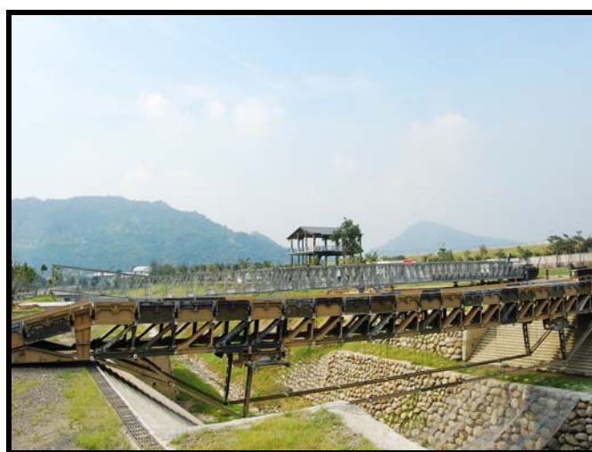
圖十三 工兵架橋訓練場
