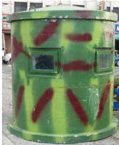
附圖 11：鋼筋混凝土預鑄式工事
