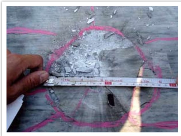
圖十五 使用游標卡尺量測坑洞尺寸
