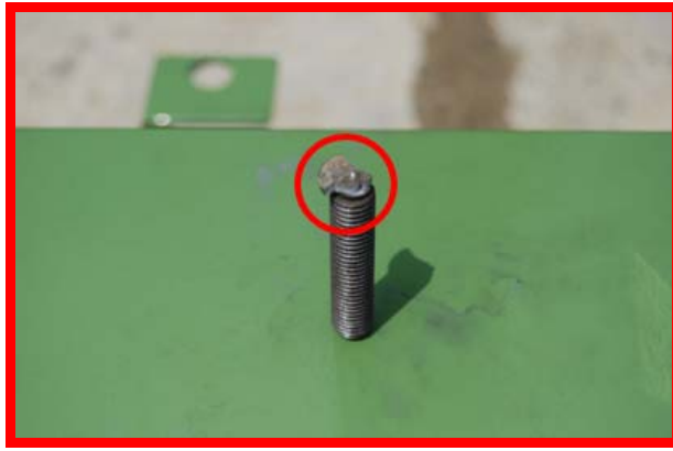
圖廿五 沖銷在拆卸過程中發生斷裂及破損 資料來源：作者拍攝
