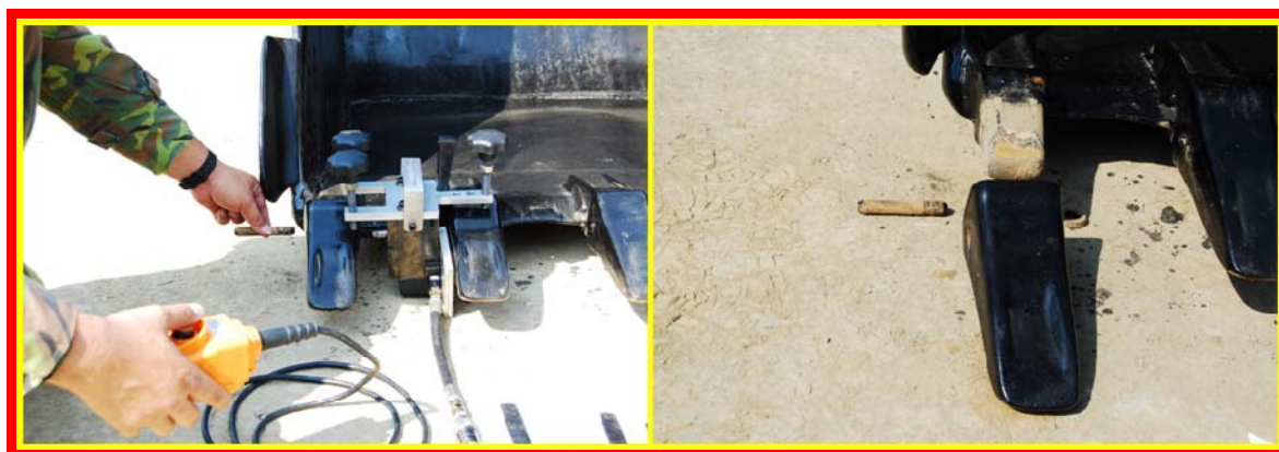
圖卅五 拆卸完成 資料來源：作者拍攝
