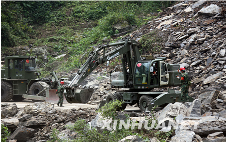
圖四 工程兵實施道路搶修作業
