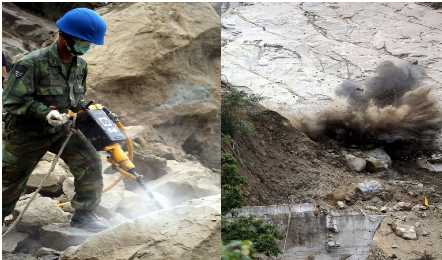
圖三十 爆破作業
