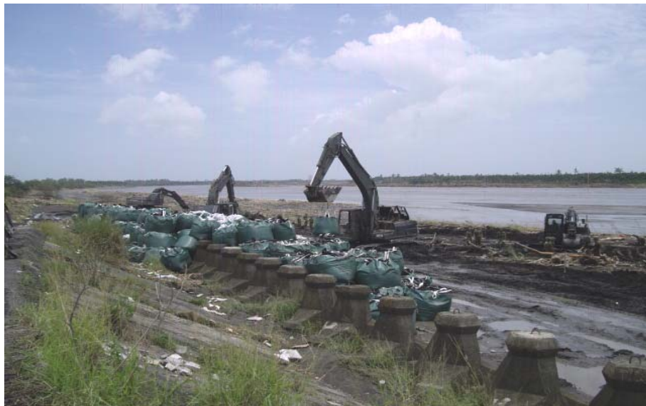
圖十九 河堤修補作業
