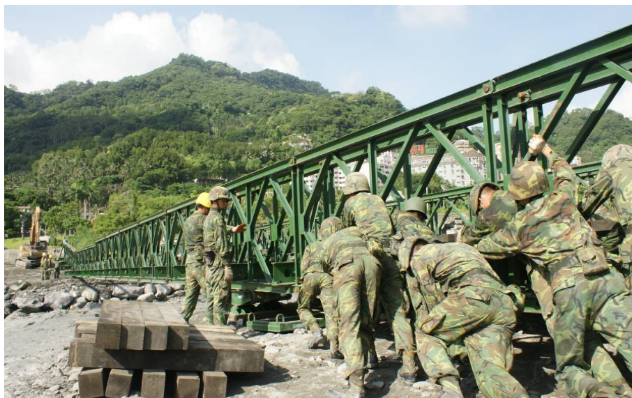
圖十七 橋樑架設作業(一)
