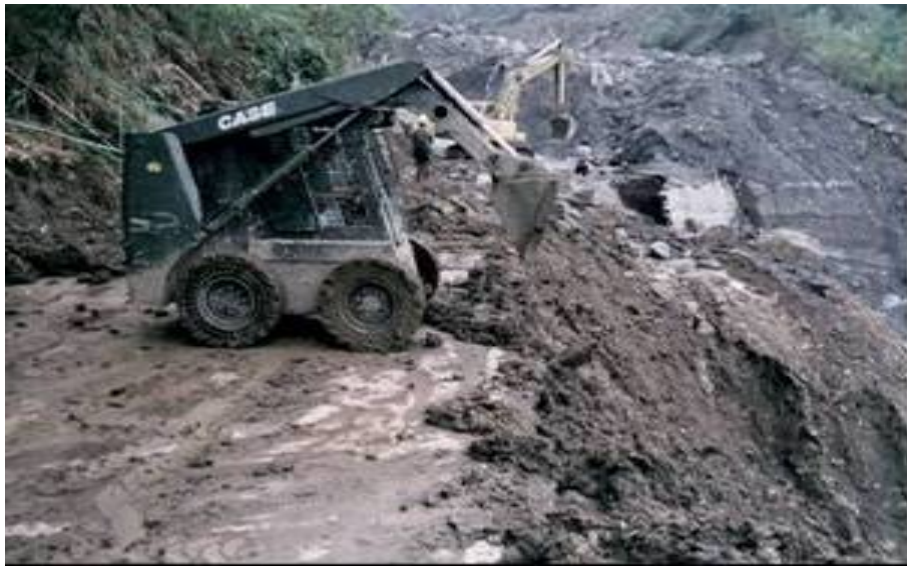
圖二十七 道路搶修作業
