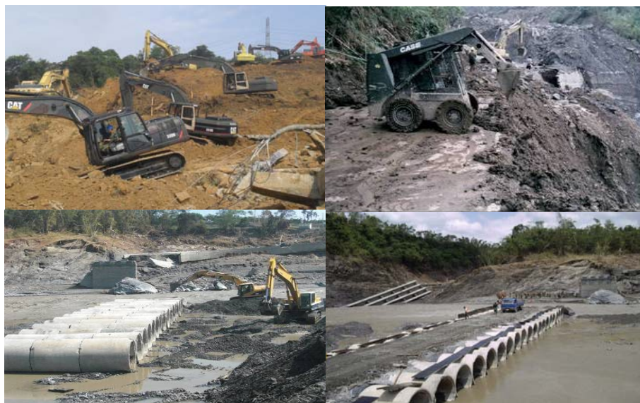
圖十五 道路搶修作業
