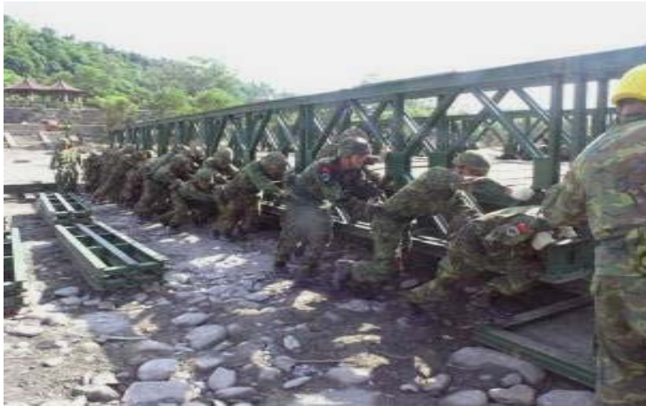
圖十八 橋樑架設作業(二)
