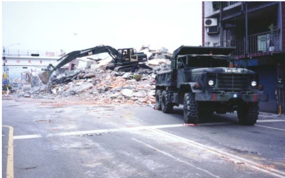
圖三十四 工兵部隊協助危屋拆除
