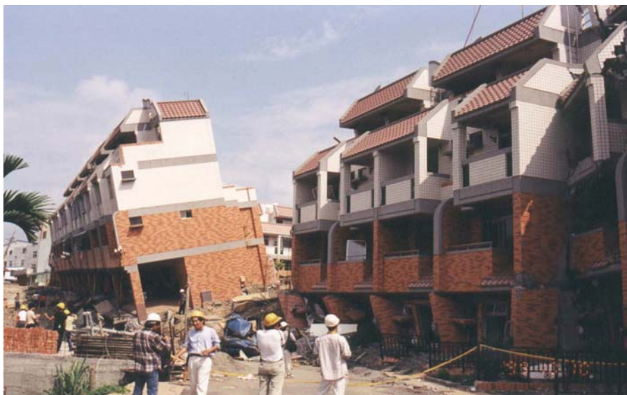
圖二 斷層通過造成住宅傾斜
