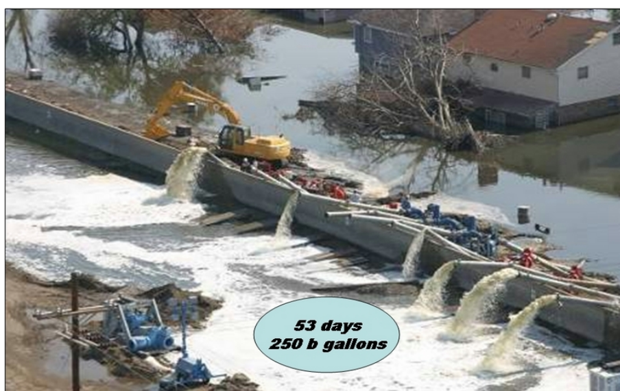
圖十一 工兵部隊協力修補堤防與抽水
