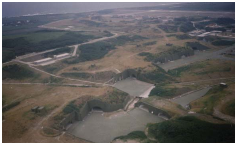
圖 15 營區工事掩體結合地形地貌
