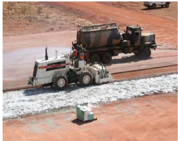
圖 13：為 RS35 拌合機作業實景
