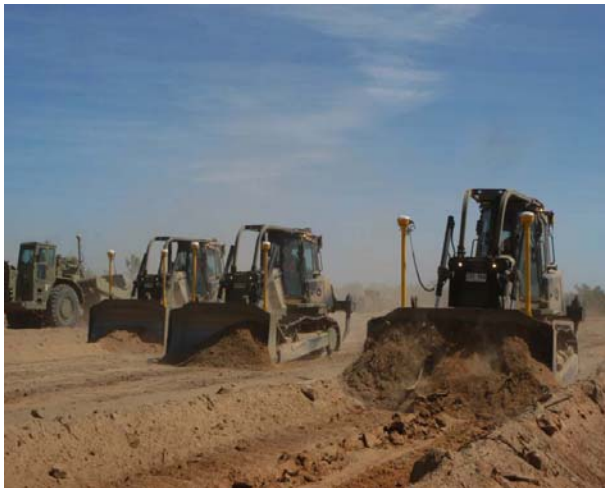
圖 9：工程控制系統(GCS)結合 GPS 輔助機具操作精度即時控制實例
