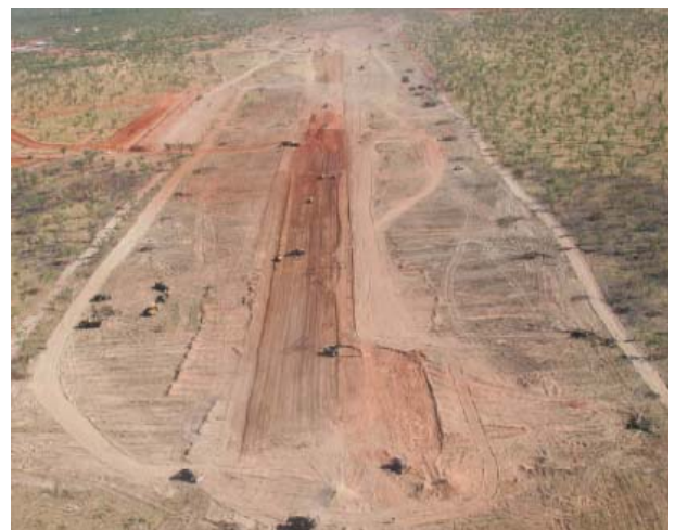
圖 12：聯合急造機場(JRAC)專案中工程機械聯合作業之空照實景
