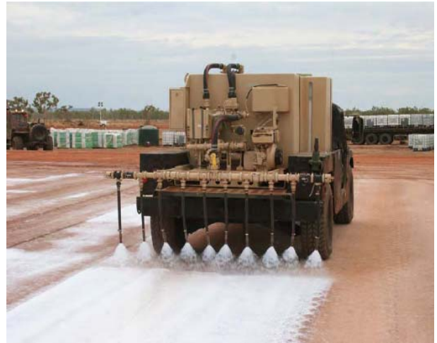
圖 14：為高機動多功能輪車(HMMWV)噴灑乳化聚合物 (polymer) 作業實景
