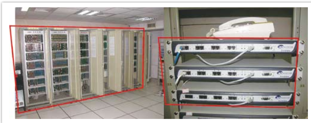
圖三 KY-1000A交換機與IP PBX交換機
