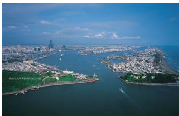
圖8 海城鎮—高雄港
