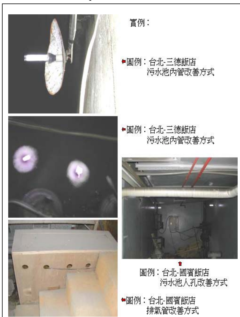
圖 5 污水處理系統加裝紫外光燈
