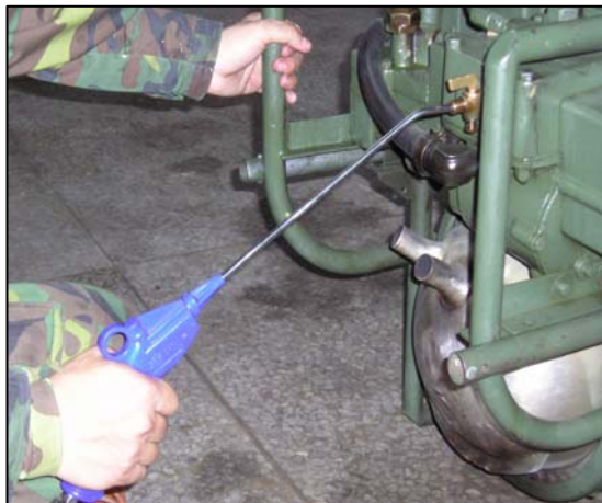
圖 12 打氣進洩壓活門
