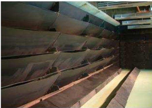
圖五：靶場鋼質被彈面
