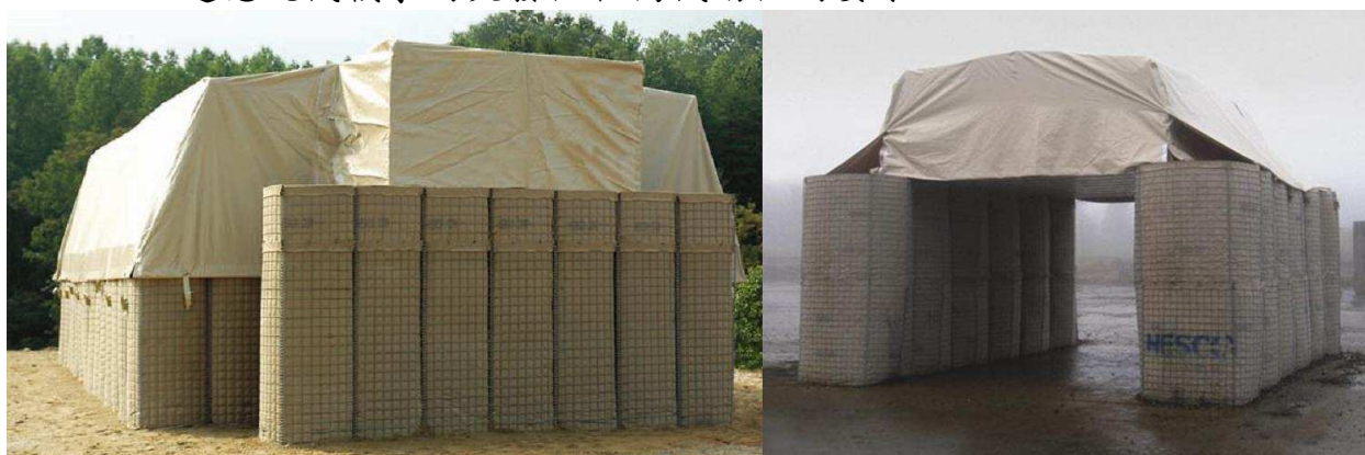
圖附三：英國 HESCO 公司運用纖維織物與鋼絲網組成預鑄式野戰工事，裝填泥土或沙，多個堆疊一起組成掩體，加強防護能力。
