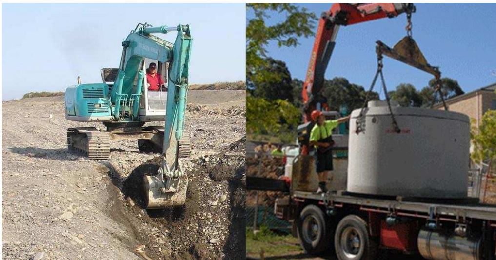
附圖十一：運用民用工程機械挖掘與吊運協助構築野戰工事，可大幅節省部隊的人力與時間。
