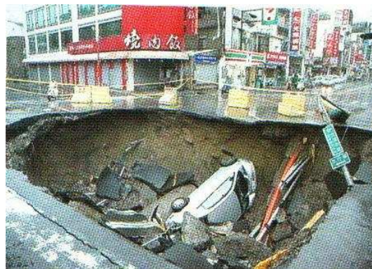
圖二：台南市永康市道路受損淘空，車輛掉落坑洞
