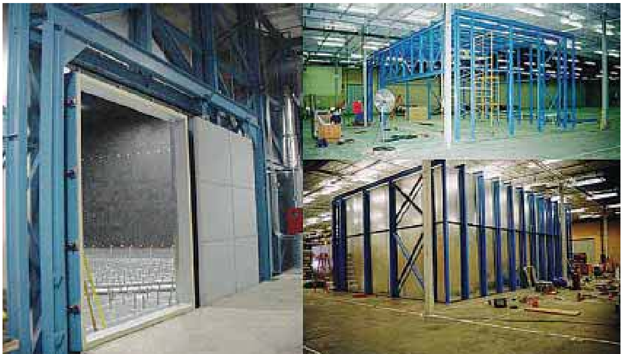
圖 11 電磁脈衝屏蔽隔離工程
