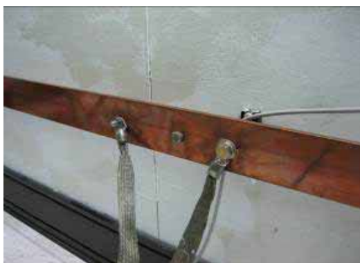
圖 5 接地銅板及地線
