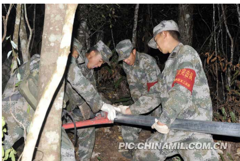
圖2 駐滇某工兵團為當地彝族村寨鋪設引水管
