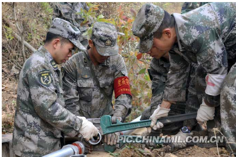
圖1 駐滇某工兵團為當地彝族村寨鋪設引水管
