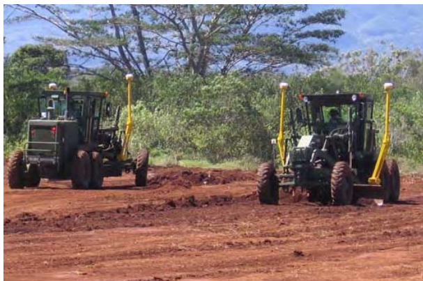
圖 27 工程控制系統於平路機應用實例
